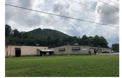
Plant-II, Emporium USA
