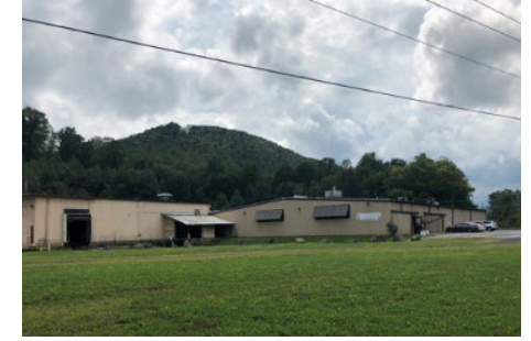
Plant-II, Emporium USA
